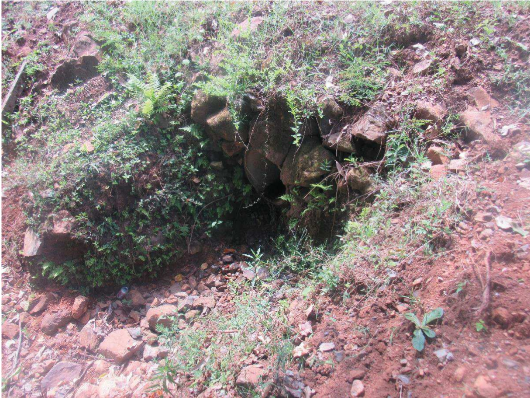
Figura 77: Final da tubulação, no ponto R104
