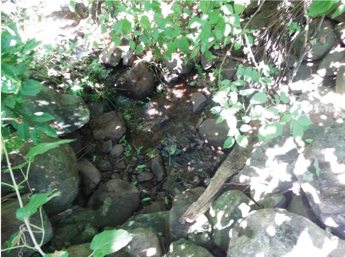
Figura 73: Início da tubulação do curso d'água "E", no ponto R17
