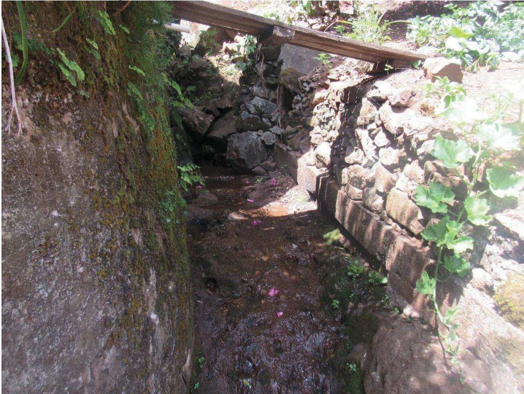
Figura 79: Início da tubulação, no ponto R3
