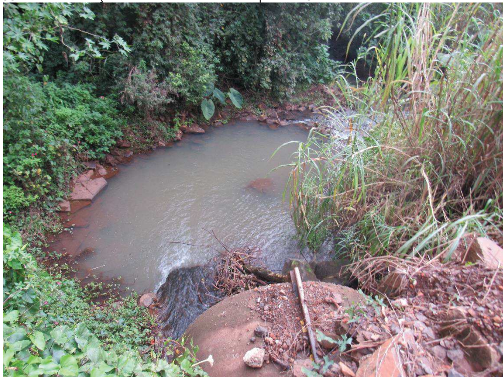
Figura 138: Saída tubulação do “Arroio Pacifico” no ponto R54.
