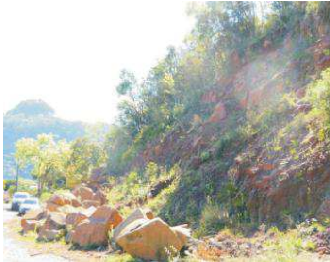
Figura 20: Talude de corte da encosta
