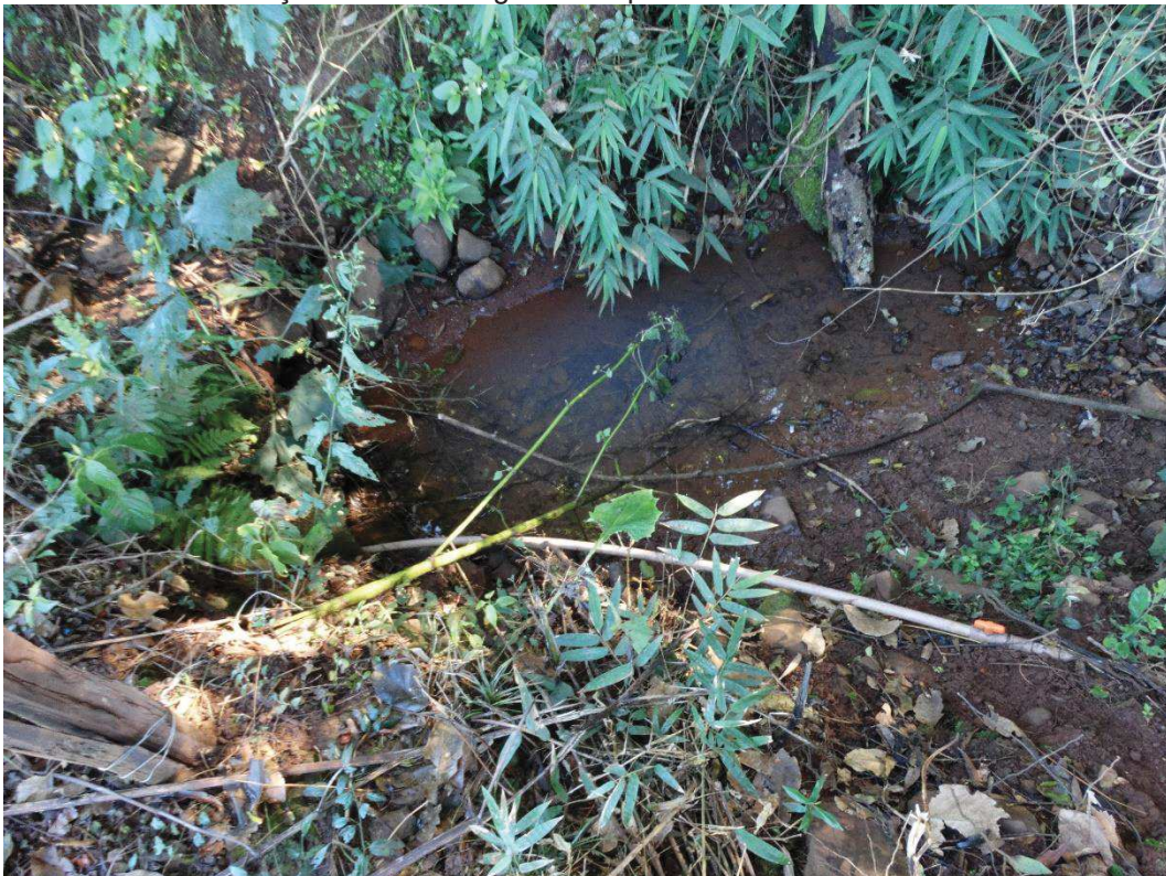
Figura 130: Início da tubulação do curso d'água "1" no ponto R34
