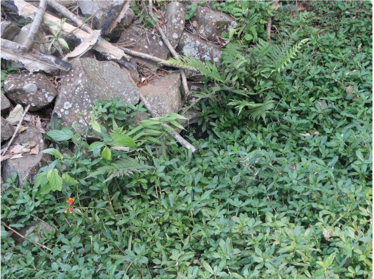
Figura 136: Saída tubulação curso d'água "H" no ponto R33.
