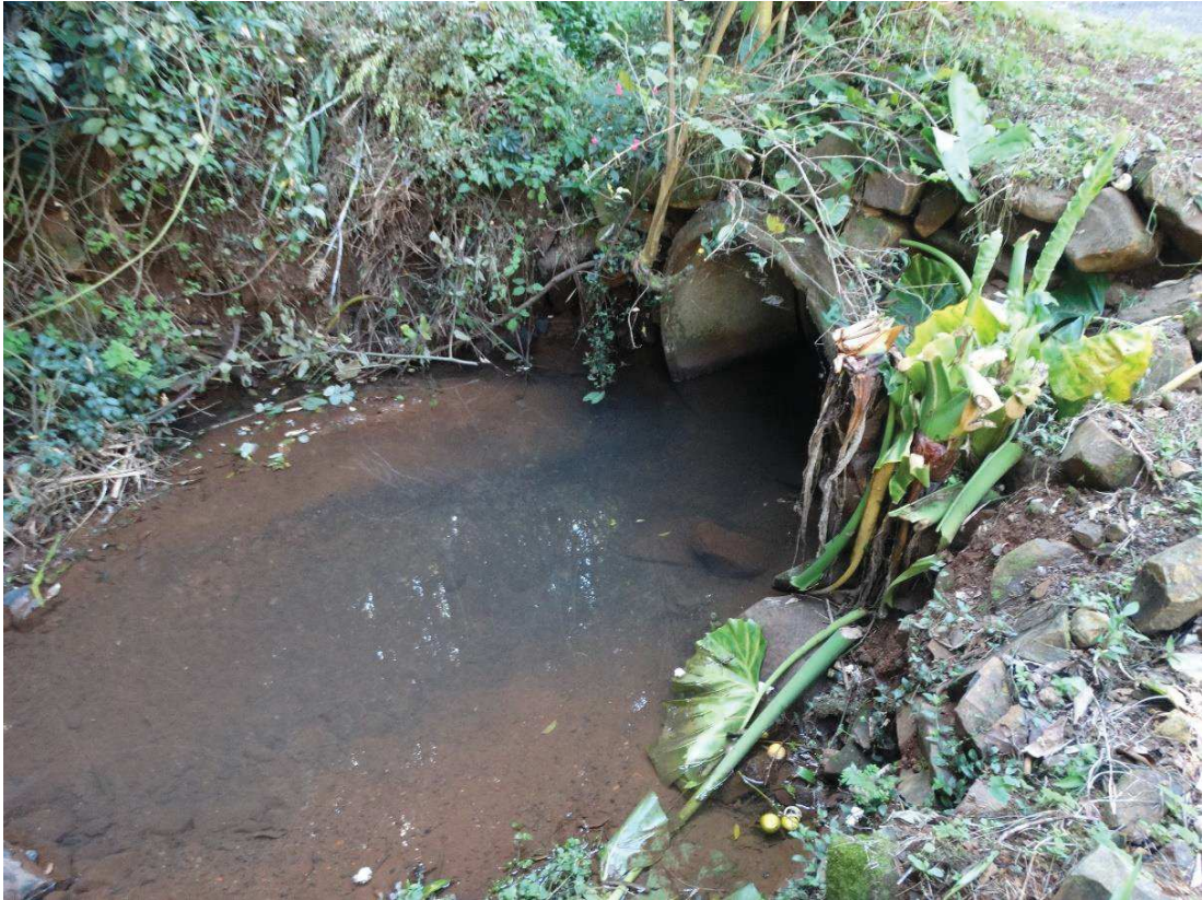
Figura 66: Final do primeiro trecho tubulado do curso d'água "E", no ponto R16
