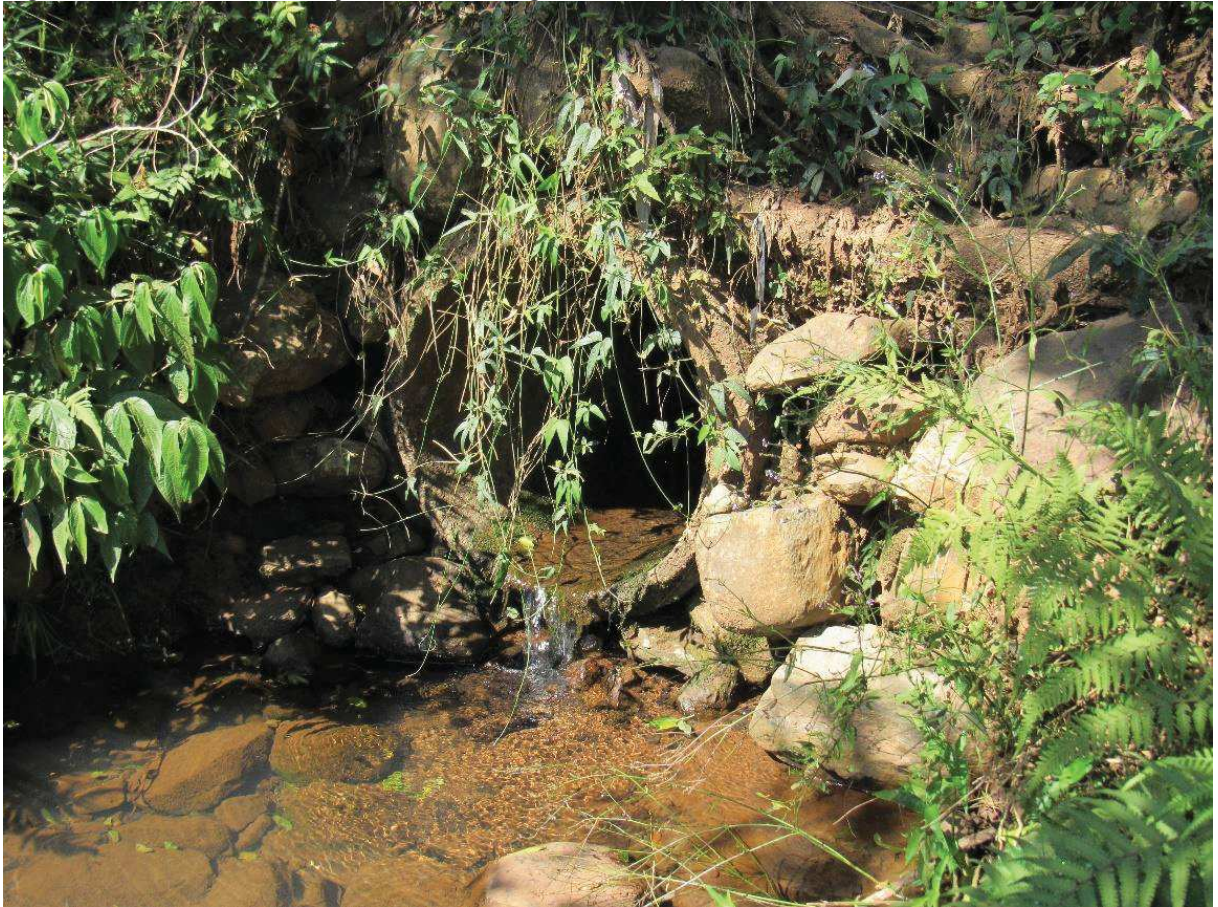
Figura 148: Saída da tubulação do curso d'água "M3" no ponto R84.
