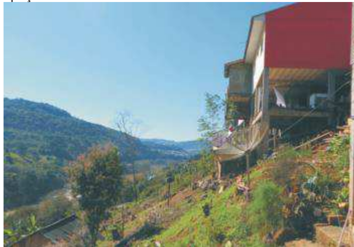
Figura 15: Tipo de ocupação da encosta
