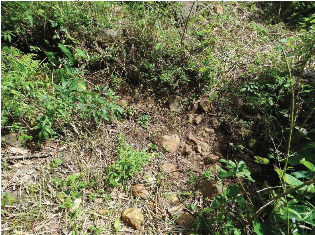
Figura 93: Trecho de drenagem descaracterizado na reambulação, no ponto R18
