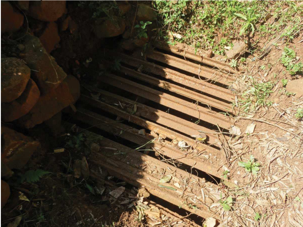
Figura 80: Tubulação onde ocorre o encontro entre os cursos d'água "E" e "E2" no ponto R94
