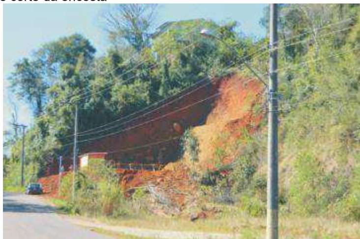
Figura 16: Talude de corte da encosta
