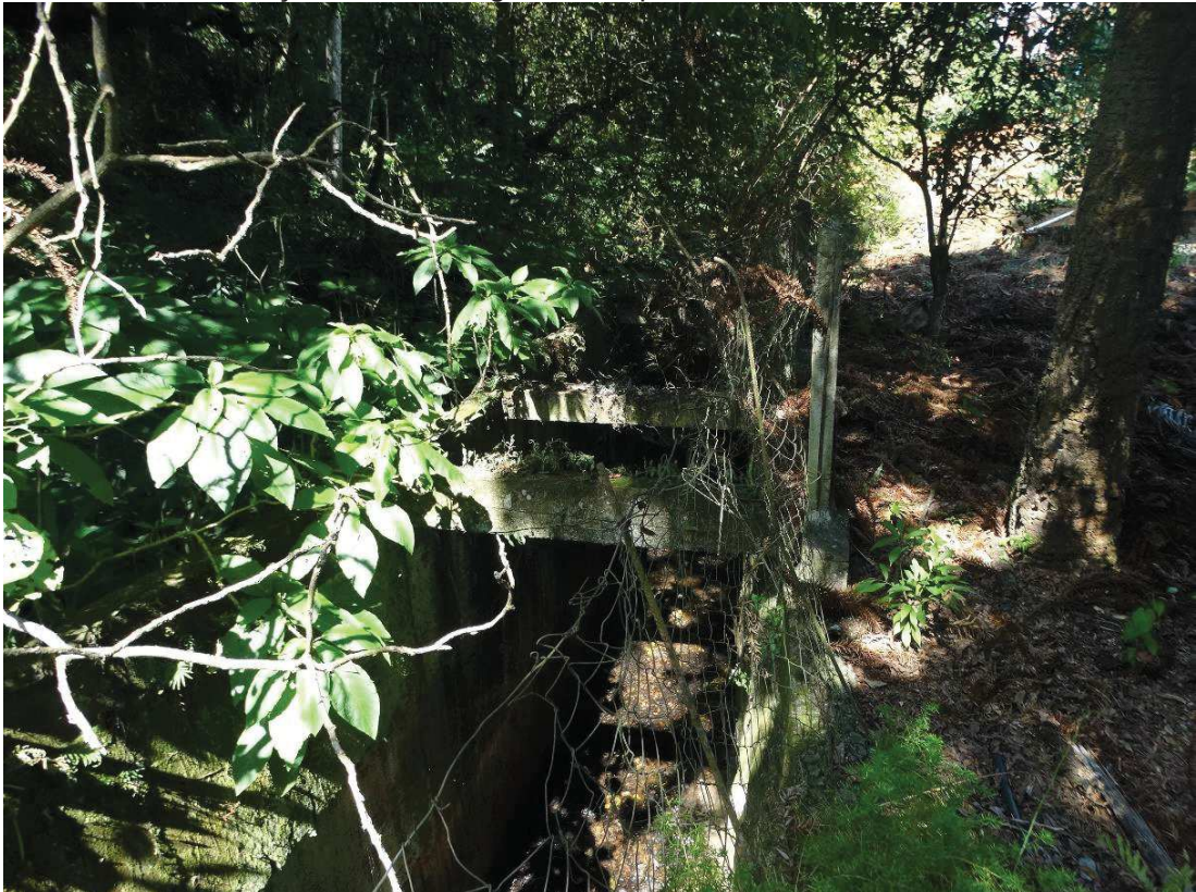
Figura 69: Início da tubulação do curso d'água "F", no ponto R96
