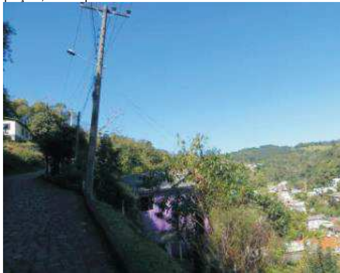
Figura 19: Tipo de ocupação, muito próximas ao talude
