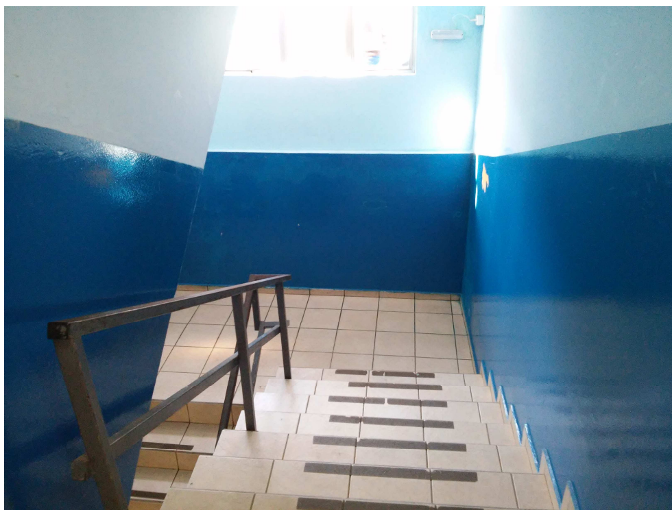
Imagem 01 – Corrimão e guarda corpo na escada interna
