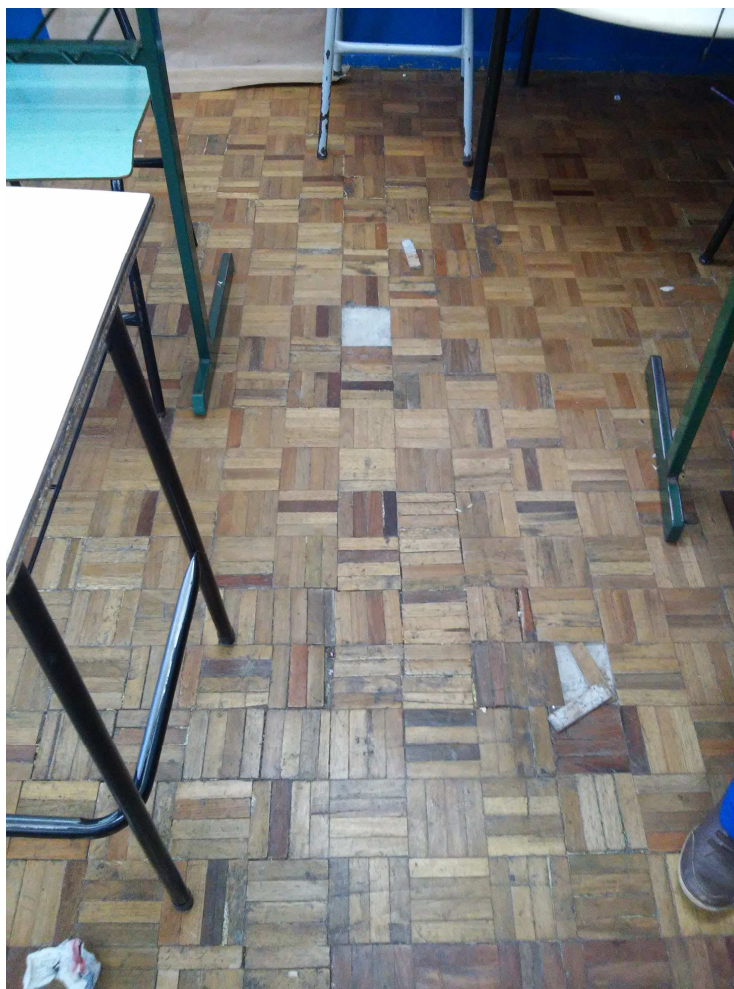
Imagem 08 – Remoção piso existente e substituição por piso cerâmico
