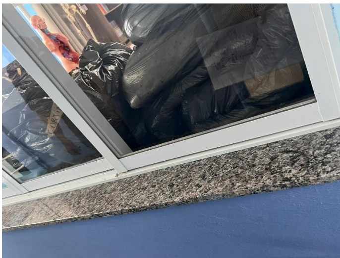
FOTO REPRESENTATIVA, PINGADEIRA EXISTENTE NA EDIFICAÇÃO
